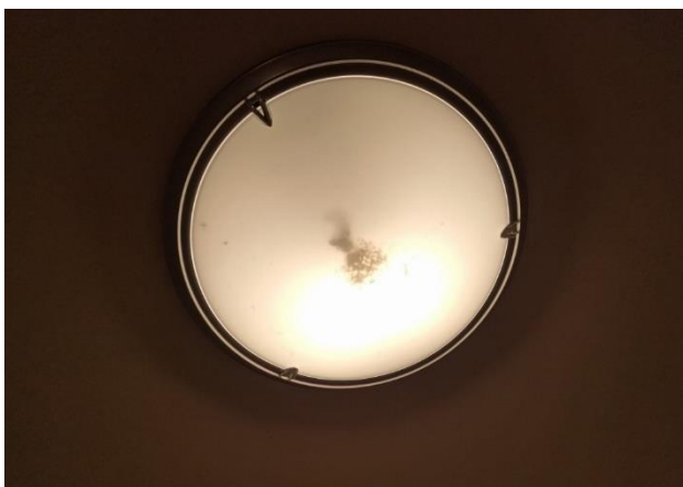
5.9.5.att. Gaismekļa iekšpusē iekļuvušas mušas
