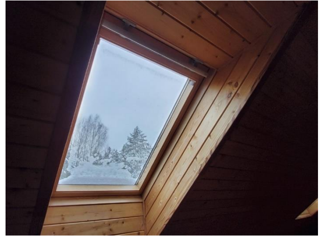
4.13.2.att. Jumta logs otrajā stāvā
