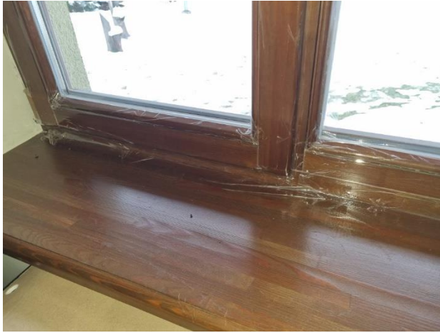
4.13.1.att. Logs aizlīmēts ar līmlentņu
