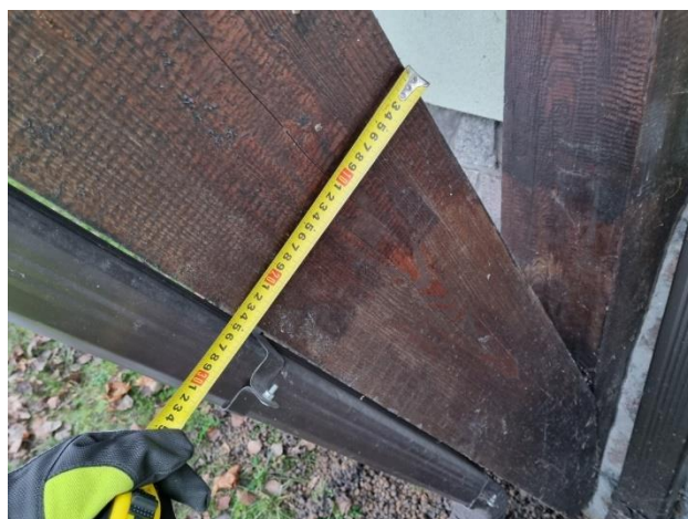
4.8.6.att. Atgāžņi atbalsta jumta pārkares konstrukcijas
