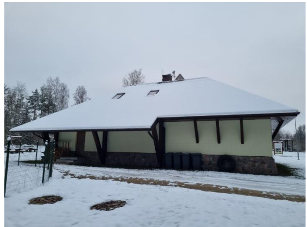
4.8.2.att. Skats uz ēkas jumtu
