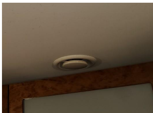
5.6.8. att. Griestos izbūvēts gaisa difuzors
