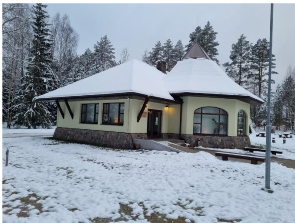
2.3.4.att. Būves kopskats no austrumu puses
