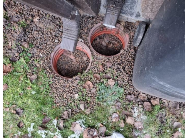
4.8.10.att. Lietus uztveršanas akām nav uzstādītas restes
