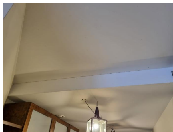
4.6.2.att. Plaisas starp pirmā stāva pārseguma ģipškartona apšuvuma loksnēm
