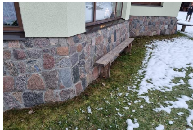
4.1.2.att. Skats uz ēkas pamatu konstrukcijām no ārpuses
