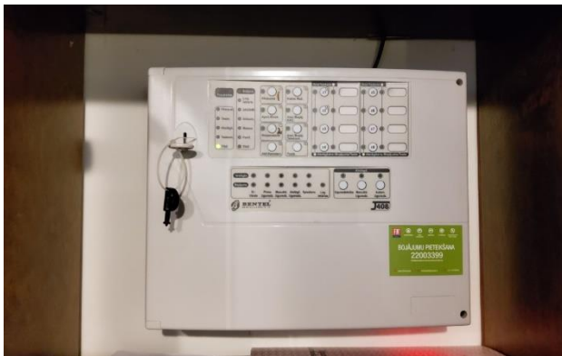
5.3.1.att. Ugunsgrēka atklāšanas un trauksmes signalizācijas sistēmas vadības iekārta „Bentel J408”
