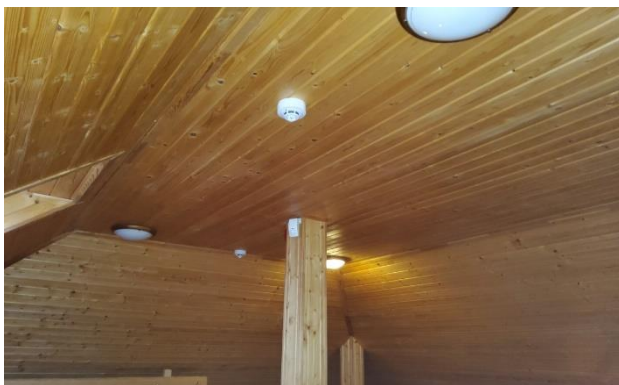
5.3.3.att. Automātiskās ugunsgrēka atklāšanas sistēmas dūmu detektori
