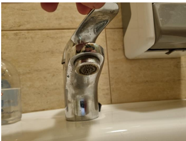
5.1.3.att. Ūdens maisītāja aerators ir aizsērējis
