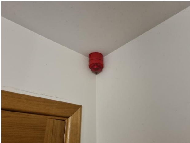
5.3.5.att. Ugunsgrēka trauksmes signalizācijas sirēna
