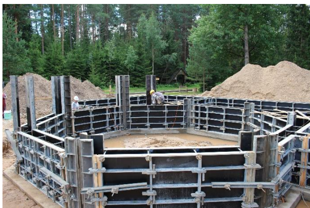
4.1.1.att. Skats uz ēkas pamatu konstrukcijām būvdarbu laikā (avots https://www.mammadaba.lv/ )
