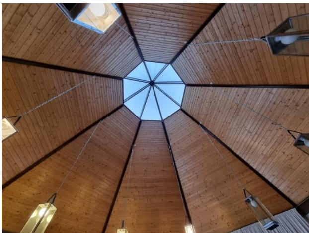
4.8.3.att. Piramīdas tipa jumta konstrukcijas
