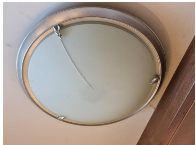
5.9.4.att. IePLīsis gaismekļa noseGPLafona stikls
