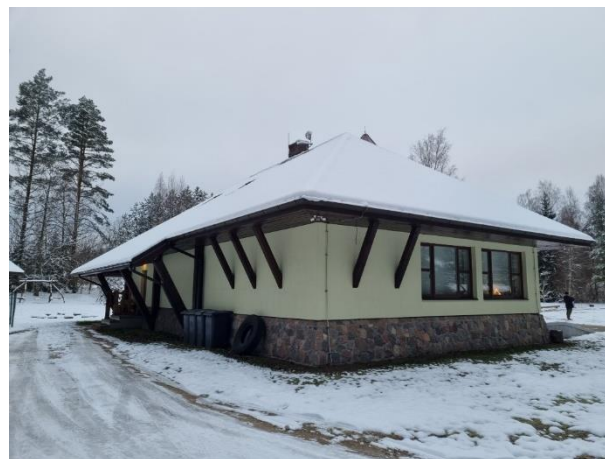
2.3.5.att. Būves kopskats no dienvidu puses
