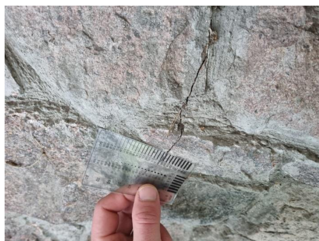
4.1.6.att. Nenožīmīga plaisa laukakmeņu apdares kārtā
