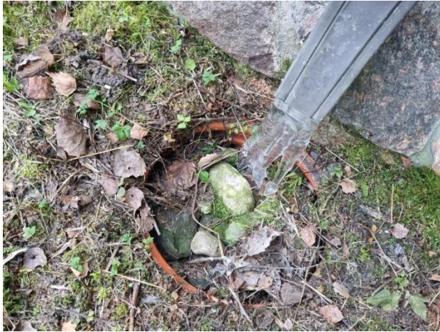
4.8.9.att. Lietus uztveršanas akām nav uzstādītas restes
