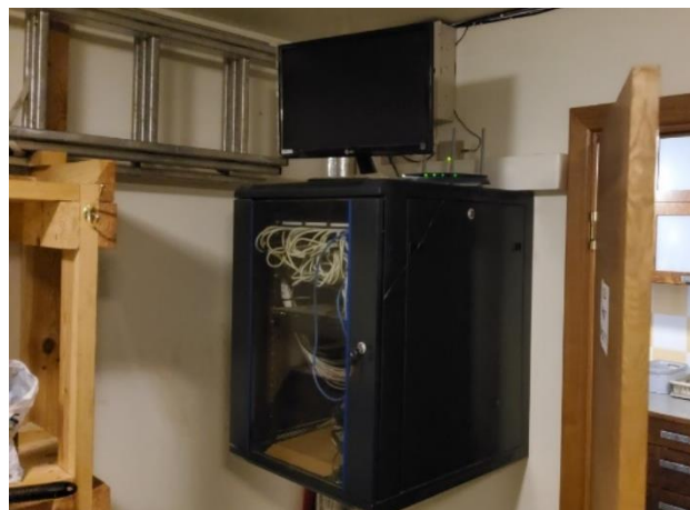
5.13.2.att. Videonovērošanas sistēmas bloks
