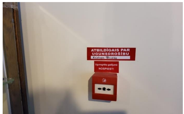
5.3.4.att. Ugunsgrēka trauksmes signalizācijas iedarbināšanas poga
