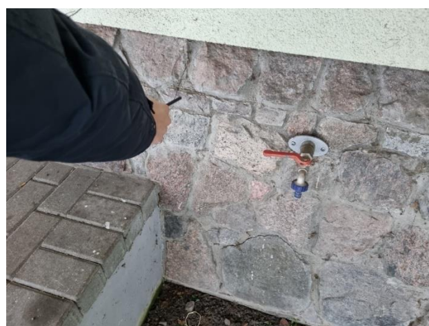
4.1.4.att. Nenožīmīgas plaisas laukakmeņu apdares kārtā
