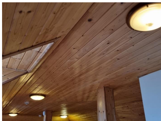
4.18.6.att. Lakotu dēļu apšuvums otrā stāva telpā
