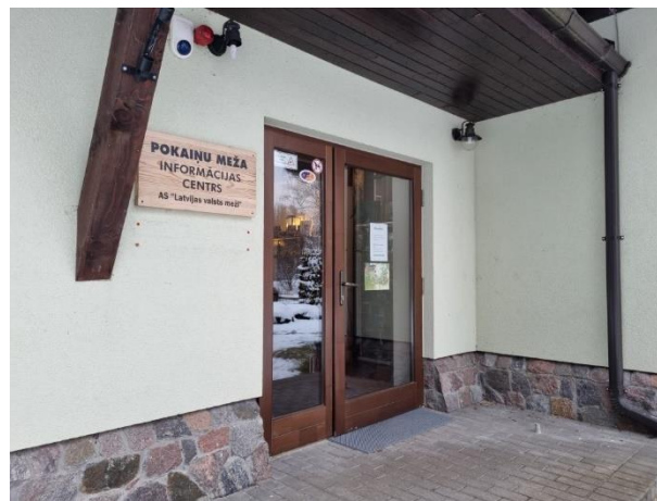
4.2.2.att. Skats uz nesošajām sienām no ārpuses
