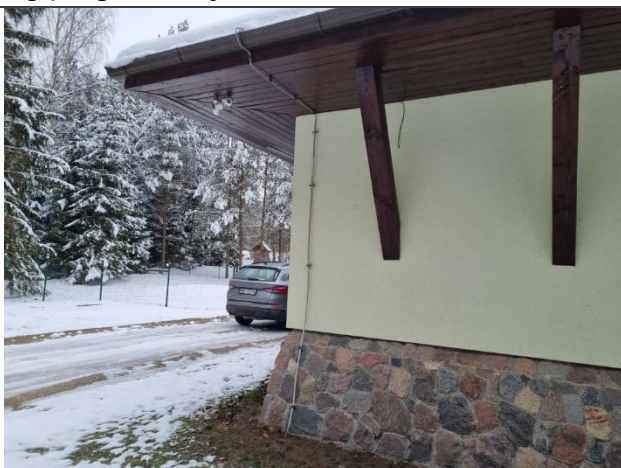
4.19.1.att. Ēkas ārējā apdare
