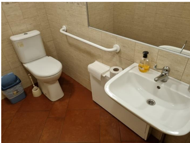
5.1.5.att. Uzstādītā izlietne un klozetpods invalīdu tualetē
