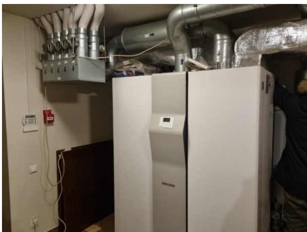
5.6.1.att. Ventilācijas iekārta apvienota ar siltumsūkni vienā iekārtā
