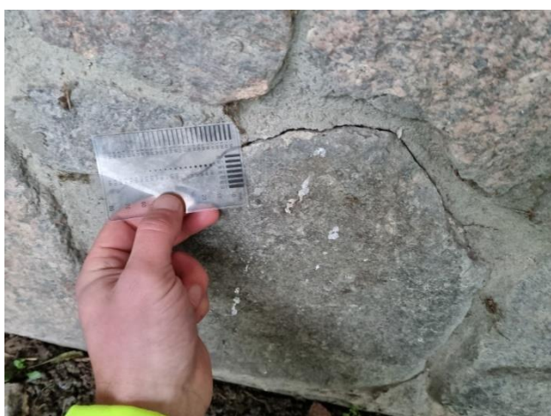
4.1.5.att. Nenožīmīga plaisa laukakmeņu apdares kārtā
