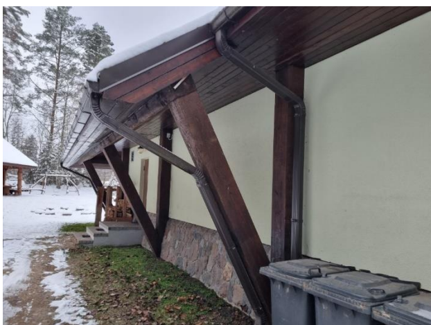
4.8.5.att. Atgāžņi atbalsta jumta pārkares konstrukcijas
