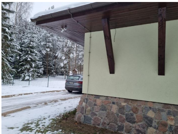
4.2.1.att. Skats uz nesošajām sienām no ārpuses
