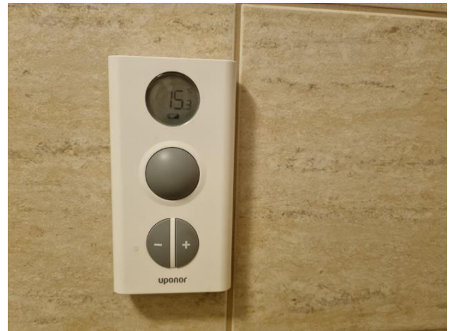
5.4.4.att. Telpu temperatūras kontrolieris
