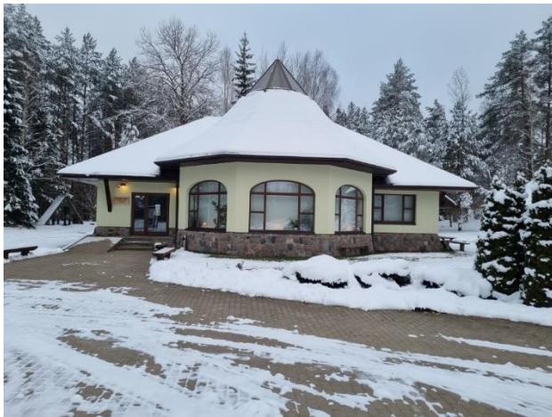
4.8.1.att. Skats uz ēkas jumtu
