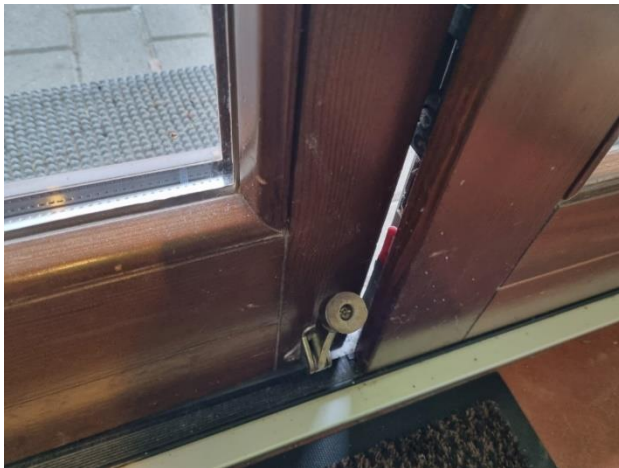
4.13.3.att. Ārējām galvenās ieejas durvīm nepieciešams veikt regulēšanu
