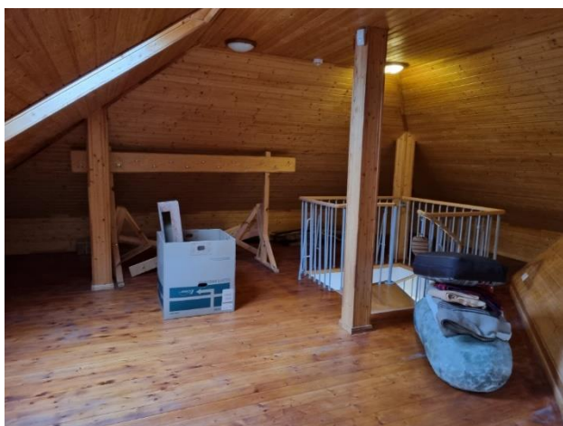
4.3.1.att. Izbūvētās kolonnas
