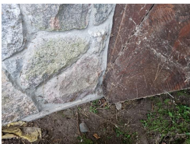
4.1.3.att. Skats uz ēkas pamatu konstrukcijām no ārpuses
