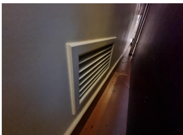
5.6.7.att. Sienā izbūvēta gaisa reste
